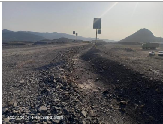
露天采场坑底（排水沟）
