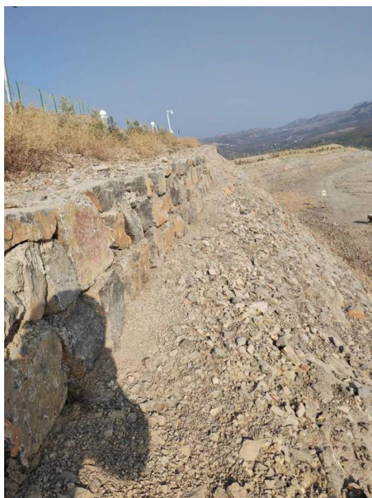
露天采场平台（挡土墙）
