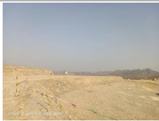
露天采场坑底（平整）
