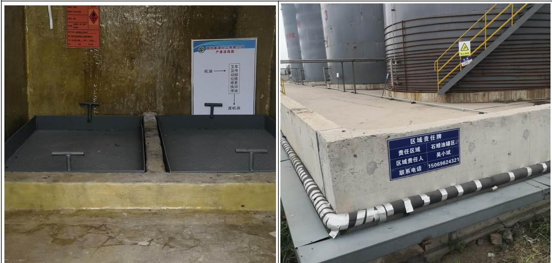
危险废物暂存间防渗
